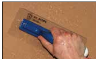
Étape 3 - à mi-séchage, resserer l'enduit à l'aide d'une spatule plastique souple.
